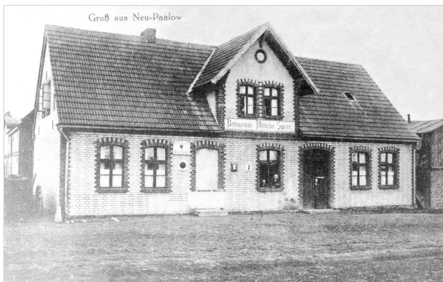
Ryc. 18. Zajazd Wilhelma Sperra w Pałówku, zdjęcie niedatowane (Anonim 1989c: 1048)
