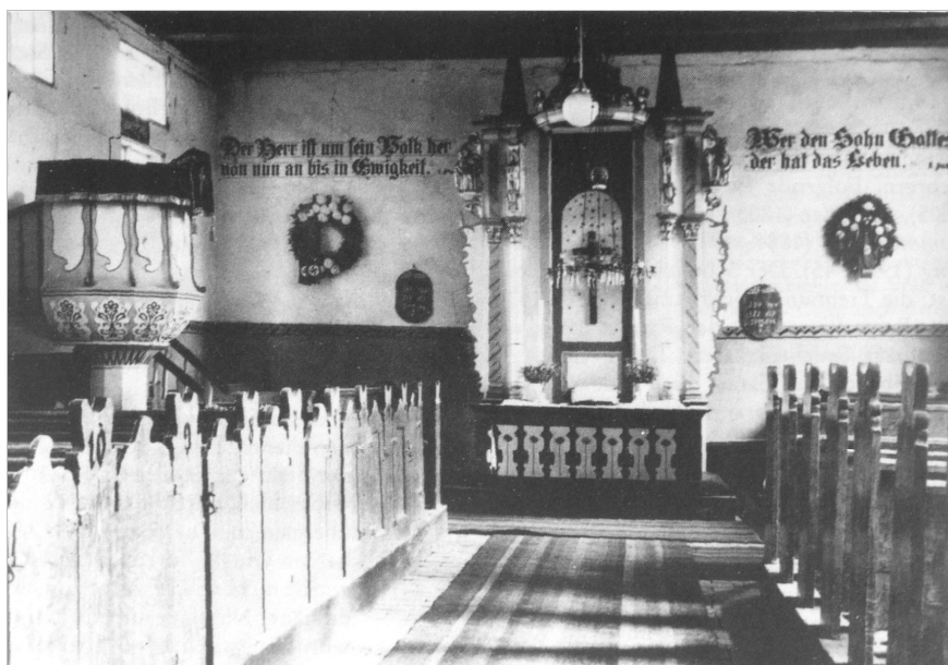
Ryc. 17. Wnętrze kościoła w Staniewicach, zdjęcie z 1938 roku (Pommerening 1989: 1217)
